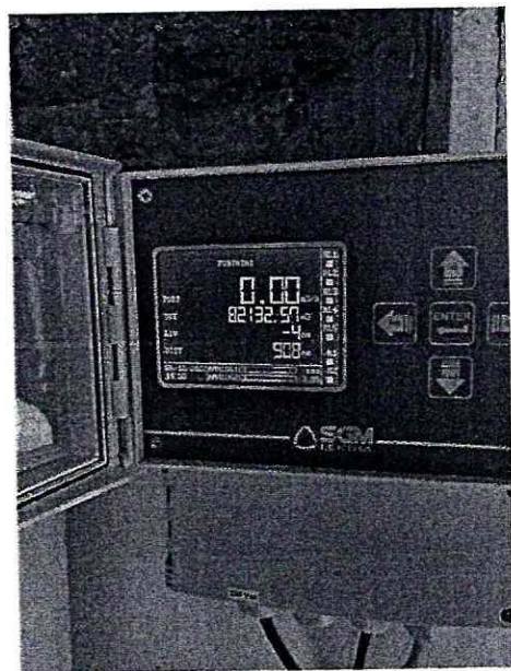
Figura 6 - Misuratore di portata in ingresso.
